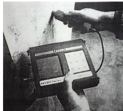
Рис.2 Процес замірів потенціалів арматури
